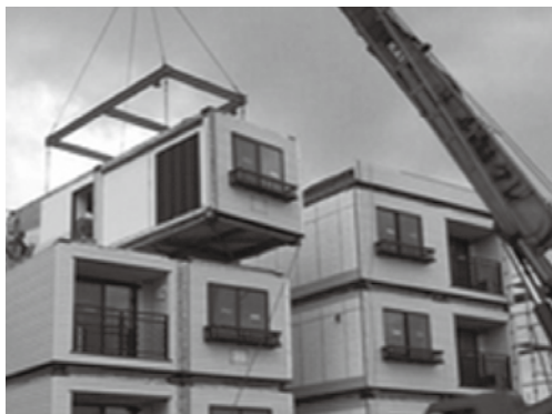
▲クレーンでつり上げたユニットを重ねるSSUT(サット)工法
