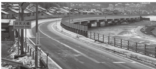
▲国道8号弁天大橋
